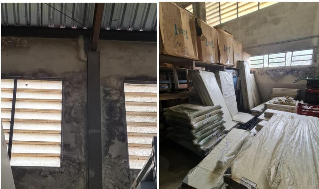
**Figuras 9 e 10 – Paredes com infiltração**
